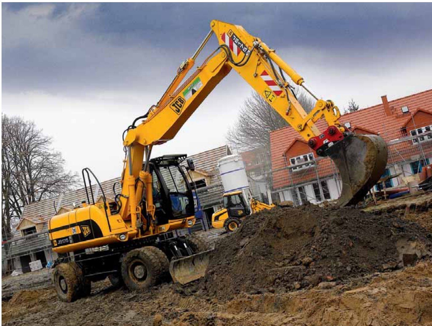
JCB JS175W mechanikus gyorscsatlakozóval felszerelve, mely gyors kanálcserét tesz lehetővé nehéz terepen is
